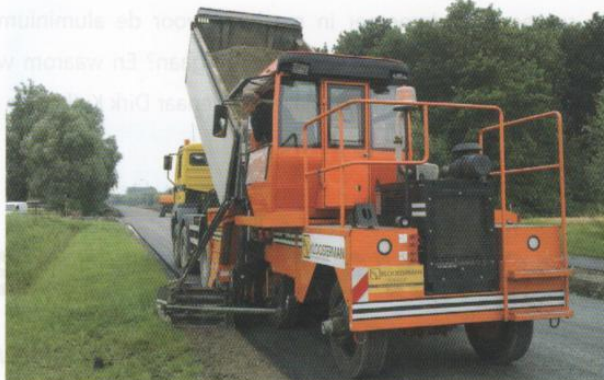
◀ De wegverbredingsmachine heeft een werksnelheid van 5 km/u. De machine vult bermen aan van dertig centimeter tot twee meter en vormt een prima combinatie met de eigen mobiele graafmachines, de vrachtwagens en de grondwals.
